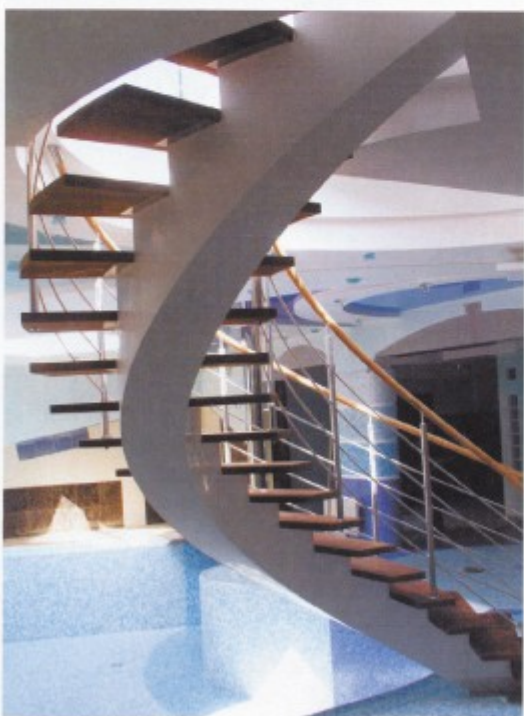
Nosná část z monolitického betonu, zábradlí je vedeno nášlapy
