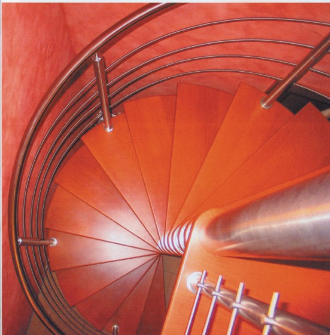
Vřetenové schodiště, kombinace dřeva a kovu
