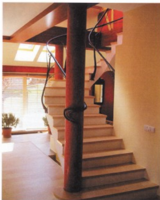
Na místě vytvořený složitý tvar monolitického betonového schodiště
